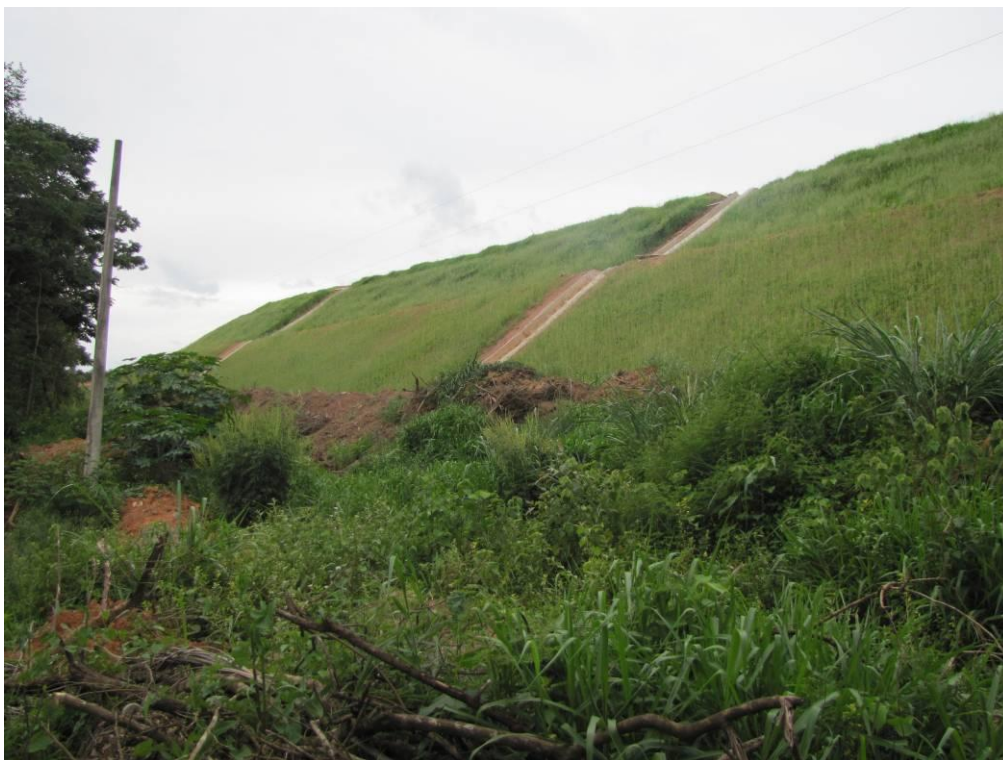
Foto 21: Talude resultante da terraplenagem, na área de instalação da nova fábrica da Toshiba.
